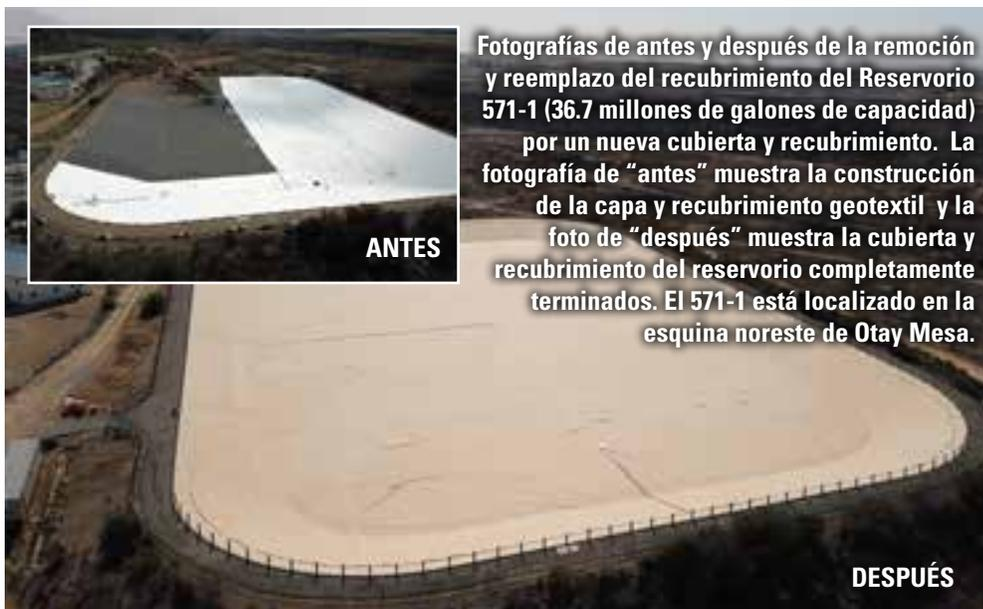
Fotografías de antes y después de la remoción y reemplazo del recubrimiento del Reservoirio 571-1 (36.7 millones de galones de capacidad) por un nueva cubierta y recubrimiento. La fotografía de “antes” muestra la construcción de la capa y recubrimiento geotextil y la foto de “después” muestra la cubierta y recubrimiento del reservorio completamente terminados. El 571-1 está localizado en la esquina noreste de Otay Mesa.
